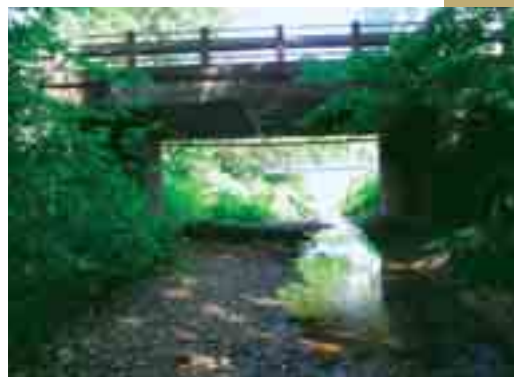
Obr. 2 Most z CAC betonu
