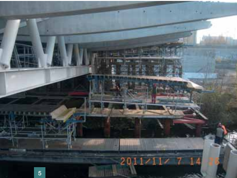
Obr. 5 Bednění desky mostovky ■ Fig. 5 Formwork of the bridge deck
