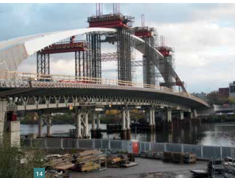
Obr. 14 Oblouk po svaření všech dílů ■ Fig. 14 Arch after welding of all parts
