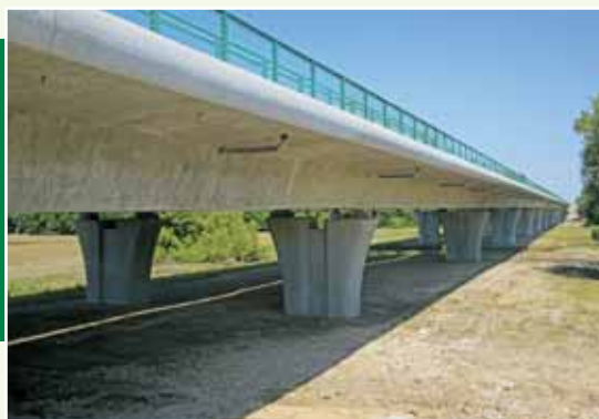
Most na dálnici D3 přes Lužnici u Veselí n. Lužnicí
