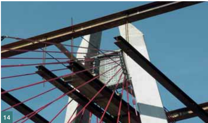
Obr. 15 Lávka I-5, montáž pylonu ■ Fig. 15 I-5 Bridge, pylon erection
