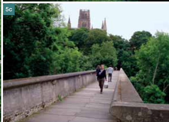
Obr. 5 Současný vzhled lávky, a) U nosník s pravidelně rozmístěnými chrliči, b) podhled lávky se štíhlými podpěrami tvaru V, c) mostovka vyskládaná z prefabrikovaných desek ■ Fig. 5 Current look of the bridge, a) trough shaped deck beam, b) soffit of the bridge with V shaped supports, c) deck of the prefabricated concrete slabs
