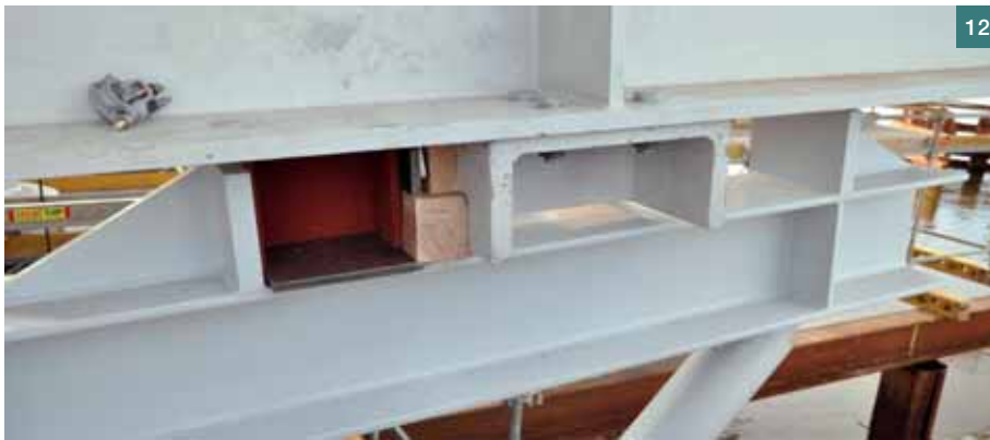
Obr. 10 Uchytení tažných tyčí do příhradové konstrukce | Fig. 10 Bars for launching, connection to the lattice structure
