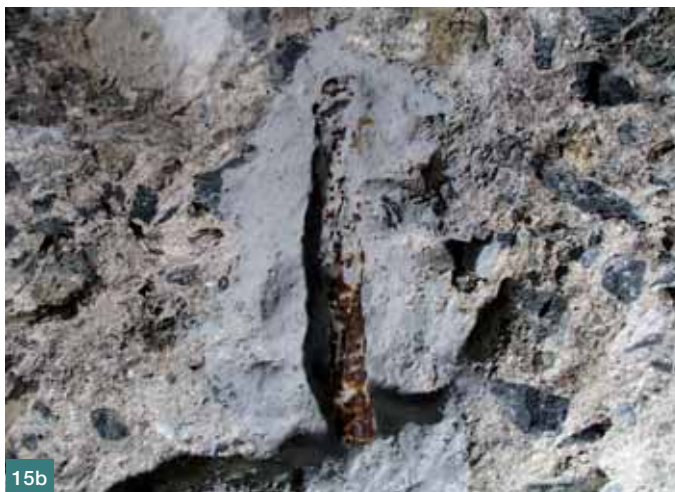
Obr. 17 Detail korozí výtzuže – před návrhem systému byl proveden nedostatečný průzkum konstrukce. Tlak chloridové korozí odtrhává krycí vrstvu z reprofilační malty a vrchní sanační stěrky s nátěrem i vrstvou původního betonu, a to čtyři roky po provedení opravy ■ Fig. 17 Detail of the reinforcement corrosion – before the design of the system, insufficient investigation of the structure had been carried out. Four years after the repairs, the pressure of the chloride corrosion removes the coat made of repair mortar and the top layer of repairing spattle together with the layer of the original concrete
