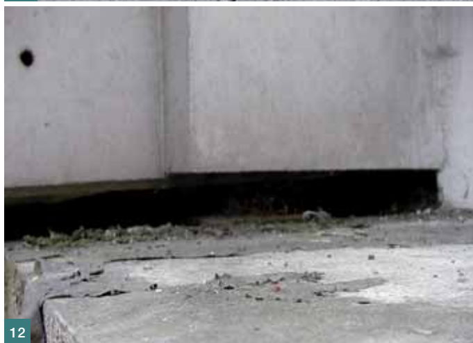
Obr. 11 Sanační povlakový systém nevhodného druhu a tloušťky, aplikovaný navíc na neupravený povrch: a) nového betonu římsy mostu, degraduje a odděluje se po cca třech letech, b) dřík opěry se stěrkou a nátěrem po deseti letech ■ Fig. 11 Improper type and thickness of a repair coating system, applied to an non-finished surface of: a) new concrete on the cornice of the bridge, degrades and falls off after cca three years, b) stem strut with spattle coat and coating after ten years
