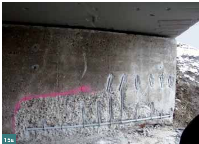
Obr. 15a, b Korozí výtzuže mostní opěry několik dní po nanesení antikorozičního povlaku na betonářskou výtzužu, ještě před zakrytím reprofilační vrstvou – důsledek nedostatečného odsolení konstrukce a vlivu blízkého zimního silničního provozu ■ Fig. 15a, b Corrosion of the reinforcement of the bridge abutment several days after applying the anti-corrosive layer to the reinforcement before covering by repair material – result of insufficiently de-salted structure and the impact of near winter road traffic
