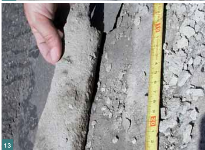
Obr. 13 Sanační povlakový systém aplikovaný na beton s nízkou odolností vůči vlivu mrazu a CHRL ve snaze zajistit u novostavby tuto odolnost dodatečným opatřením poté, když při kontrolní zkoušce nevyhověla. Oddělení povlaku s vrstvou rozpadlého betonu od podkladu ■ Fig. 13 Repair coating system applied to concrete with low resistance against frost and CDA (chemical de-icing agents) in the effort to improve this resistance at this new construction by applying an additional measure after the construction failed the check. Separated coating with a layer of perished concrete
